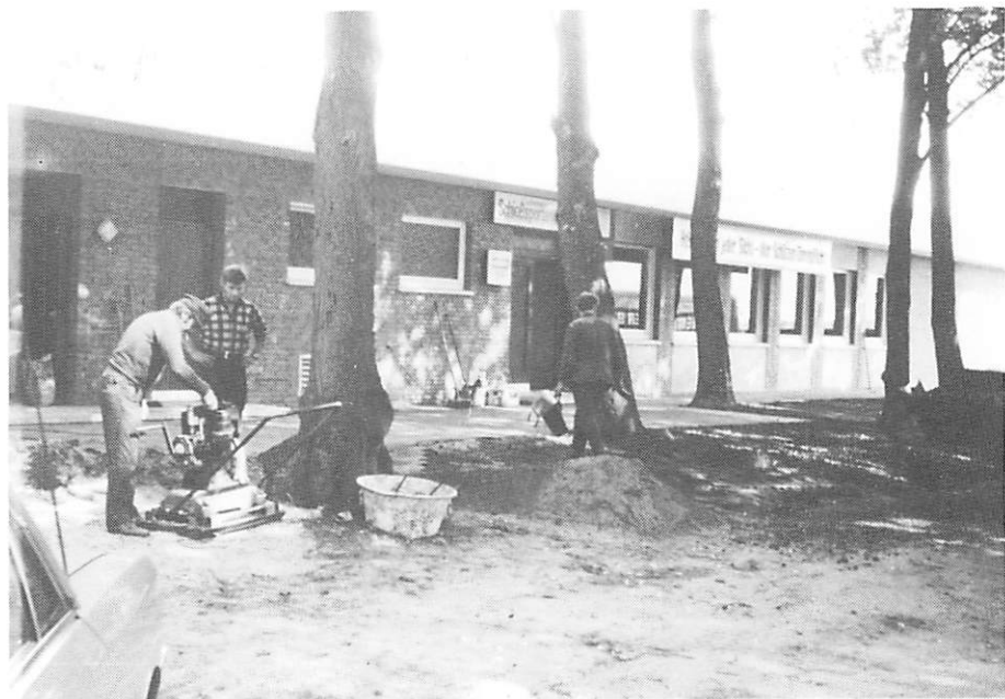
Das Werk ist vollendet. Die letzten Arbeiten an der Außenanlage werden gemacht. Rechts im Bild Franz Holthaus mit der Werkzeugtasche.
