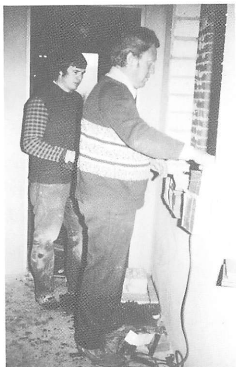
Bild links und unten: Meister, Gesellen und helfende Hän- de bewerkstelligten den Bodenbelag mit Fliesen
