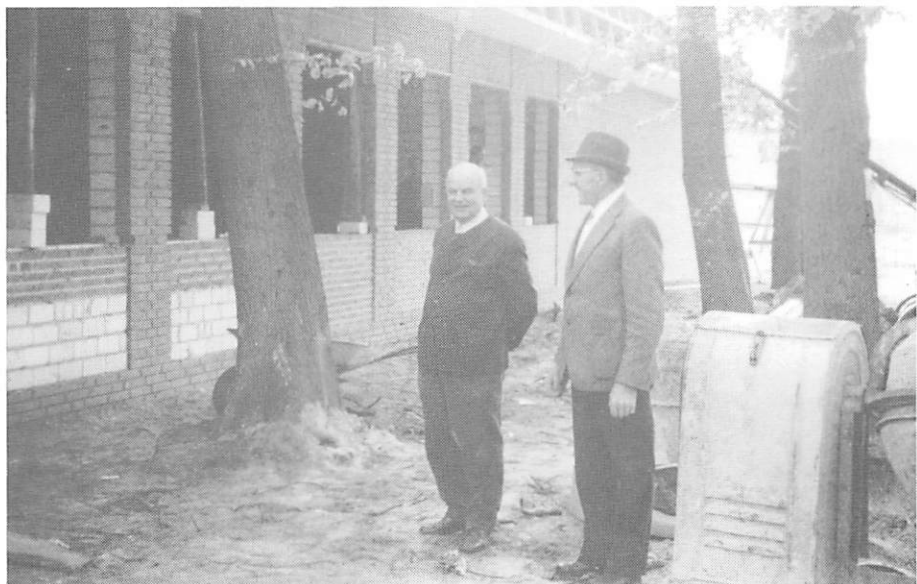
Präsident Alois Diekstall konnte gut lachen, es ging voran. Mit Alfred Sieveke, Zimmermeister, und Dachkonstrukteur an der Baustelle. Seine Zimmerleute leisteten das ihrige am Neubau
